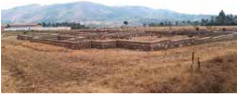
Fondations du CSO septembre 2025 - Fundamente des CSO September 2025
